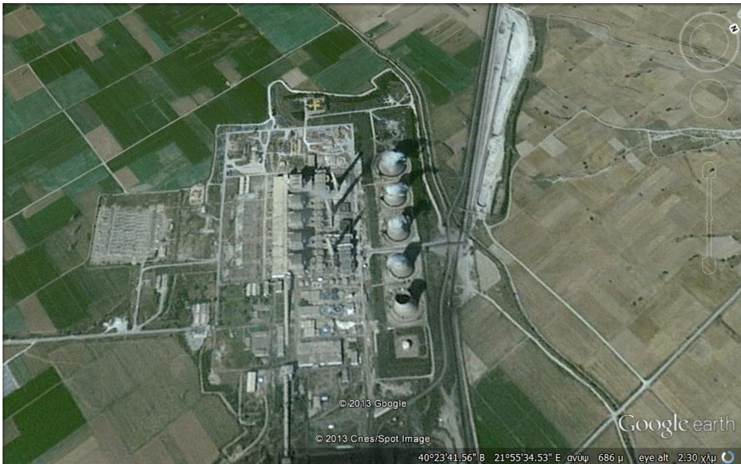
Εγκαταστάσεις μονάδας ΔΕΗ Καρδιάς – Νομός Κοζάνης ΠΗΓΗ: Google Earth
